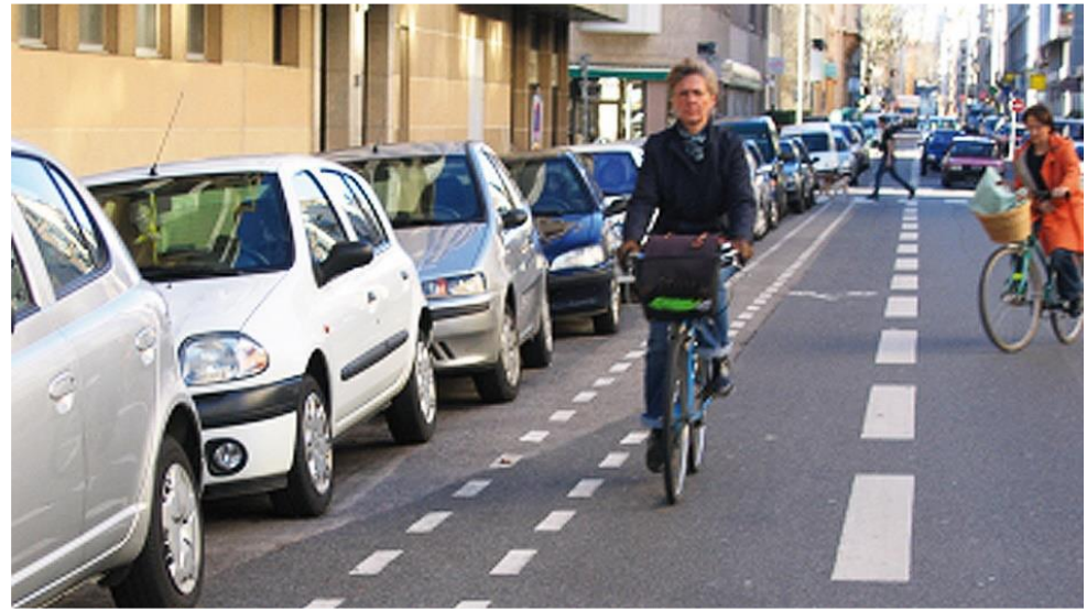
Bande cyclable avec espace tampon de 0,5 mètre
