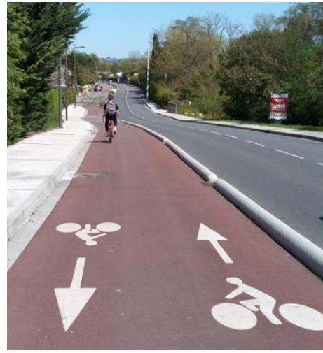
Piste cyclable bidirectionnelle sur chaussée avec séparateur physique. Pictos vélo et couleur de chaussée différente
